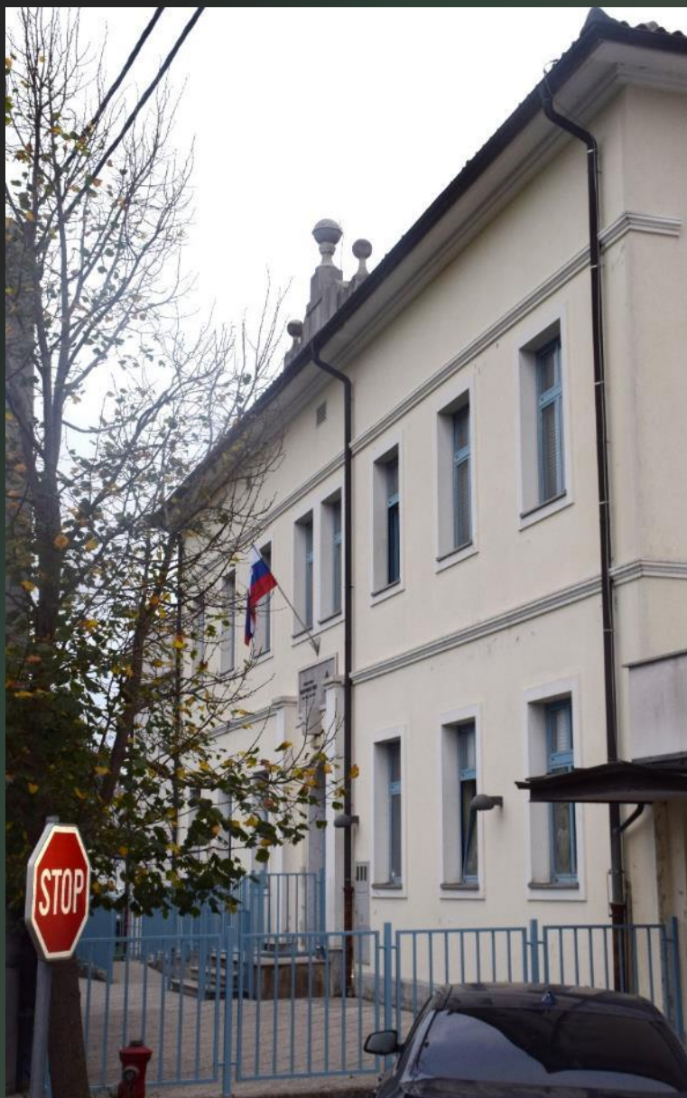
Šolsko poslopje je bilo zgrajeno l. 1911,
